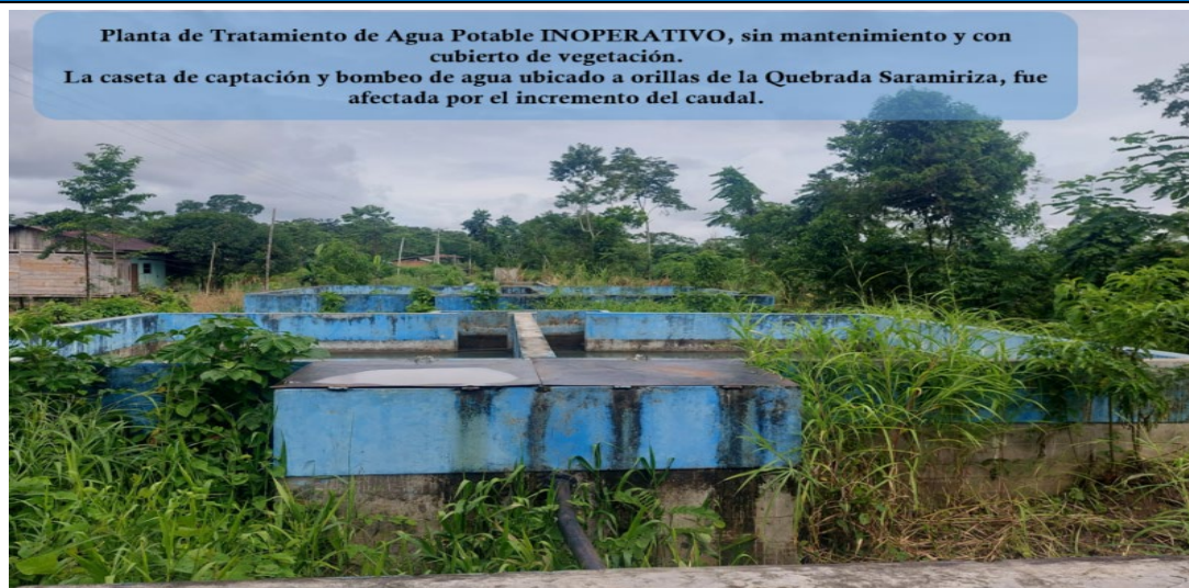
FIGURA N°01: CASETA Y BOMBEO DE AGUA EXPUESTA A INUNDACIÓN FLUVIAL
