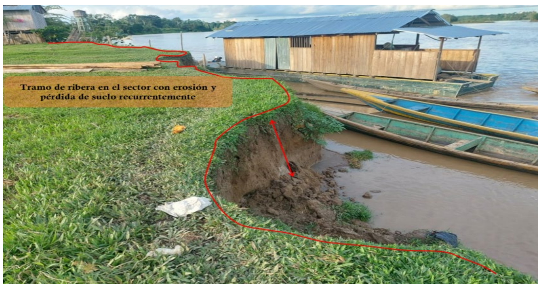
FIGURA N°05: SE EVIDENCIA EROSIÓN FLUVIAL
