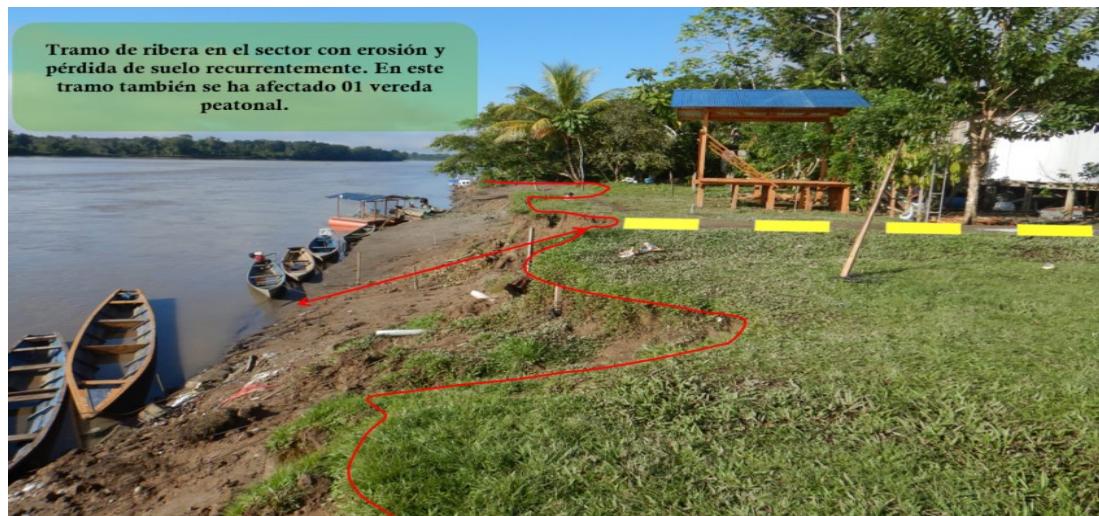
FIGURA N°04: AFECTACIÓN DE LA VEREDA PEATONAL Y ELEMENOS EXPUESTOS
